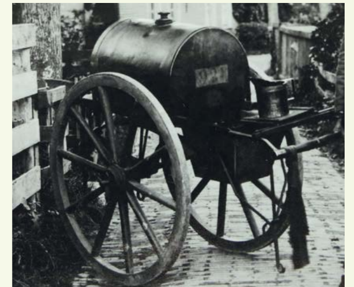
Waarschijnlijk heeft Co Meijer een oliekar als deze gebruikt. Aan de voorkant zie je een ijzeren pin waar een hond aan vastgebonden kon worden om de kar te trekken.
